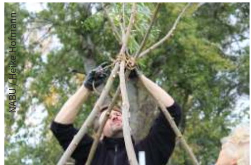
Abb.: Die Weidenruten werden oben zusammen gebunden.
