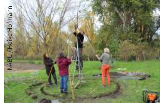
Abb.: Die dicken Weidenruten werden in den Graben gesetzt
